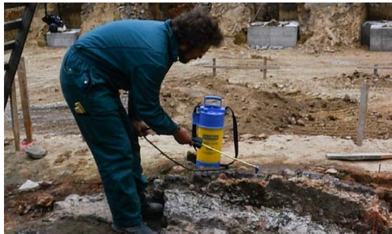
5 Mit einer Gartenspritze kann die verglaste Oberfläche dosiert freigespült werden (Dorette Klein).
