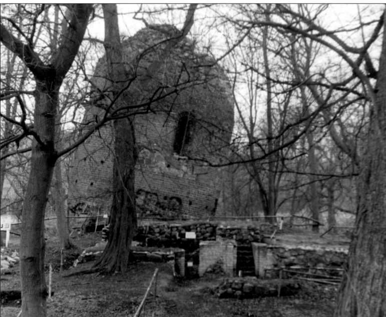
Abb. 5: Burgruine Galenbeck (Besonderer Augenmerk lag hier auf den bei einer Belagerung stark beschädigten Turm) (Foto: Michas/Gransow).
