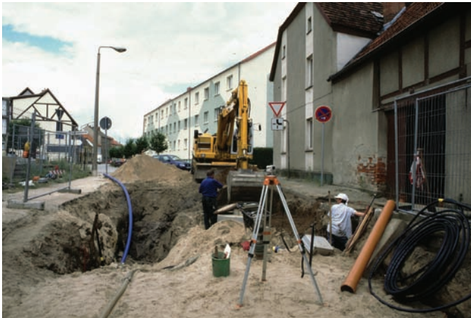
Typische Situation bei einer Rettungsgrabung im Zuge Leitungslegungen (M. Fendt)
